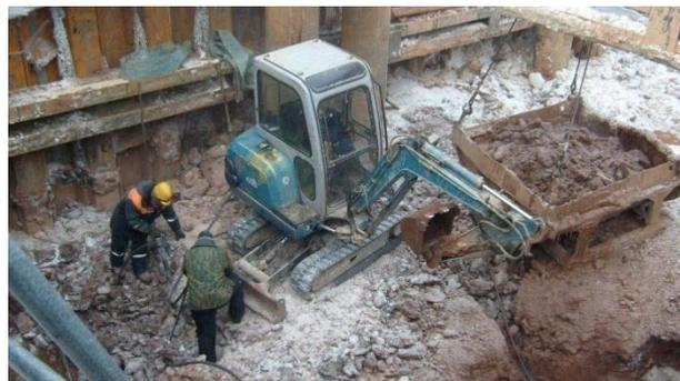
Рисунок 4.5.2 – Разработка котлована для возведения фундамента промежуточной опоры в русле реки
