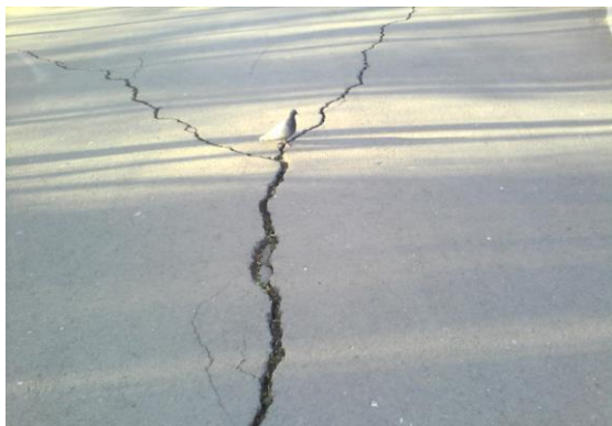
Рисунок 10.1 – Разрыв дорожной одежды в результате пучения грунта земляного полотна
