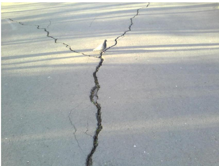
Рисунок 6.1 – Разрушение дорожной одежды в результате пучения грунта земляного полотна
