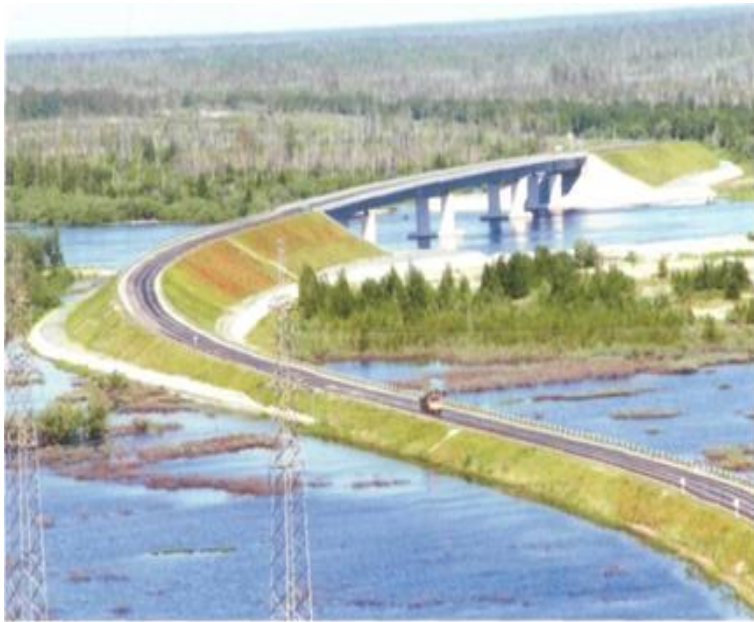
Рисунок 4.22 – Мостовой переход через Обь в г. Ханты-Мансийске
