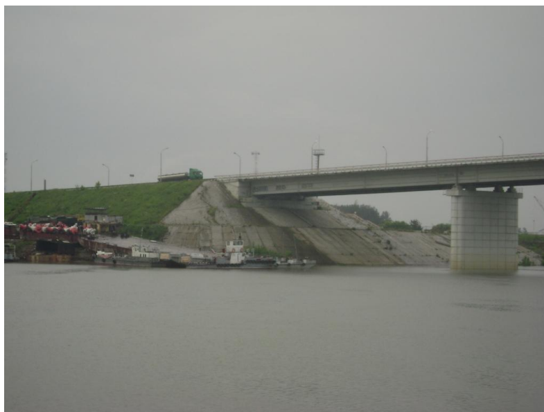
Рисунок 4.20 – Сопряжение струенаправляющей дамбы с конусом насыпи на переходе р. Томь в г. Томске
