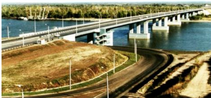
Рисунок 4.10 – Пример мостового перехода с промежуточными опорами смешанного
